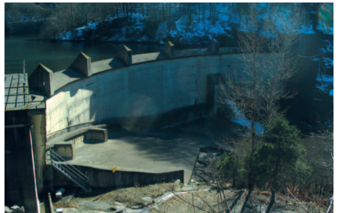
Figure 1 : Photographie depuis l'aval, en rive droite.
